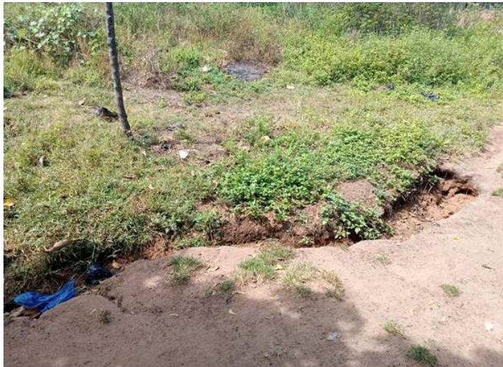
Vue partielle d'une piste dégradée par l'eau de ruissellement
