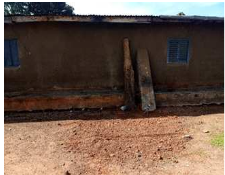
Murs soutenus par des terrasses et dalles
